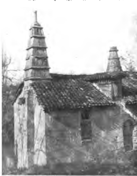
Souches de cheminées du xiii e siècle, à la Maladrerie de Couloumeix, près Périgueux.
